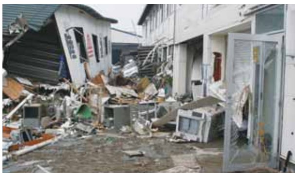
▲震災直後の仙台港事業所事務所棟と流されてきた詰所棟
