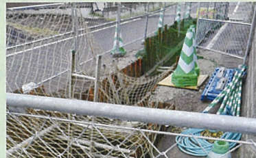
▲公共工事の地元企業の発注拡大が求められています
